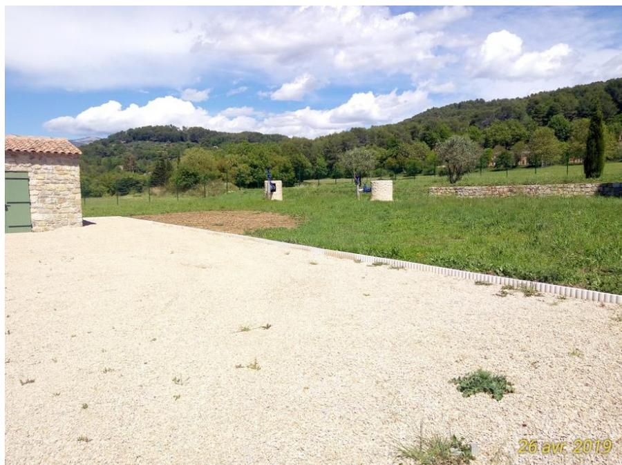
Une explication est utile concernant les deux forages à la Barrière ou Tassy<sup>22</sup>. Pour forer avec succès en nappe souterraine, on commence par forer un trou d'essai (à diamètre réduit) afin de s'assurer d'avoir l'eau en qualité et en quantité suffisante. En cas de succès, on fore ensuite à côté un trou de plus gros diamètre. On a alors deux forages productifs mais le premier est à débit
